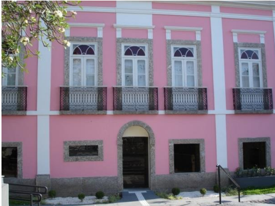
Figura 24: A “Casa Rosa” situada no bairro da Tijuca, Rio de Janeiro, atualmente propriedade do Sesc, que pertenceu a Pedro José Gomes Braga.
