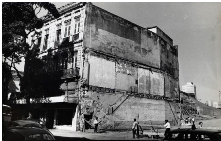
Figura 54: Casa Nunes (DECOURT, 2018).
